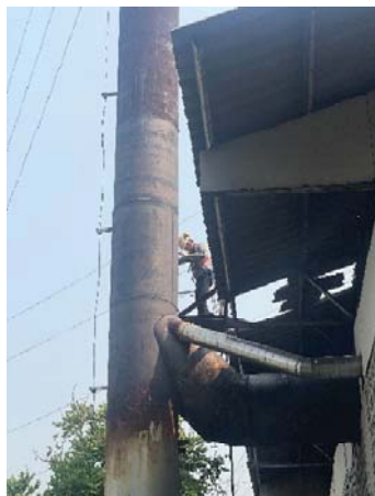
ภาพที่ 3.2.3-1 แสดงการตรวจวัดคุณภาพอากาศในปล่องเตาเผาขยะ
